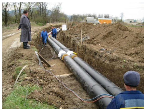
Slika 16. Polaganje predizolovanih cijevi
