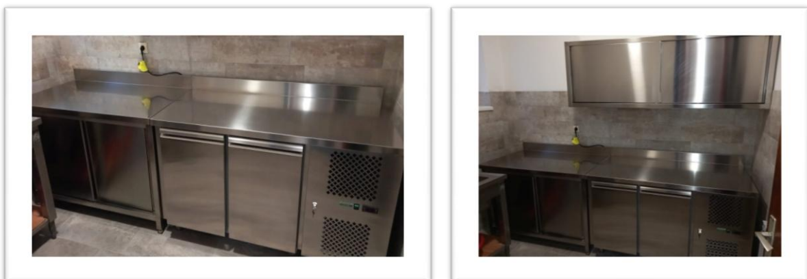
Slike: Čajna kuhinja objekat „Luke“ nakon završetka radova i postavljanja novih kuhinjskih elemenata i uređaja.
