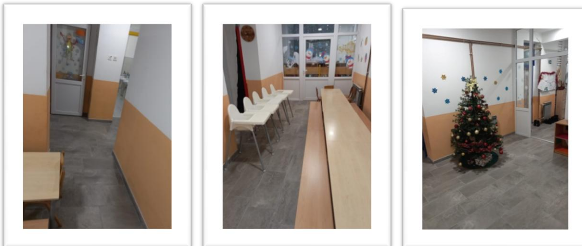
Slike: Zidovi i keramičke pločice u hodnicima i trepezariji, nakon završenih radova.
