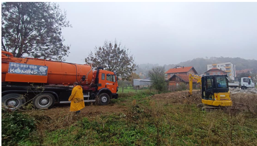
Slika 8. Čišćenje i proštopavanje kanalizacije sa Womom u ul. H Džebe Bajbage
