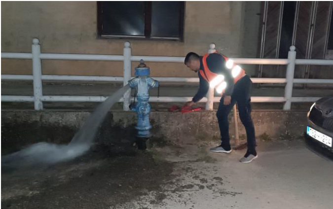
Slika 6. Redovno ispiranje vodovodne mreže
