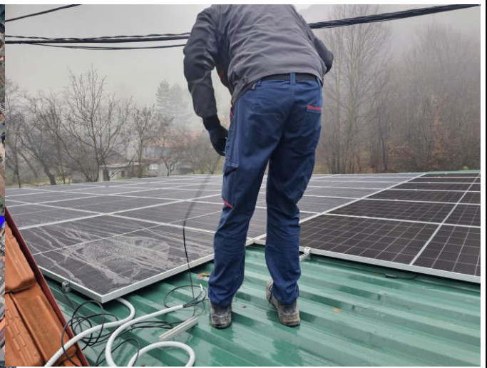
Slika 3. Izgradnja solarne elektrane 34 kW
