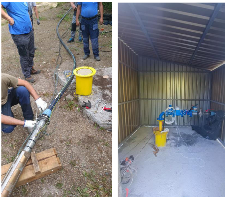
Slika 1 i 2. Radovi na interventom (privremenom) uvođenju bunara FA1
