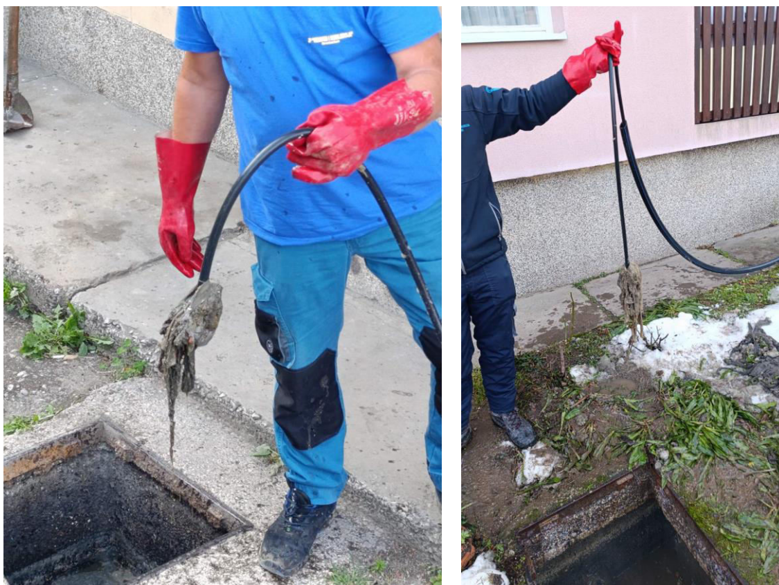
Slika 10 i 11. Problem održavanja u kanalizaciji (papirne maramice)
