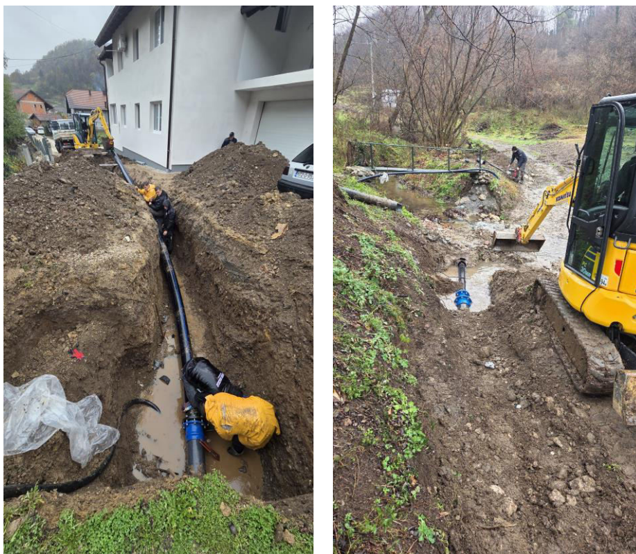
Slika 9. Otklanjanje kvara na glavnom dovodnom cjevovodu iz Sokola DN 225
